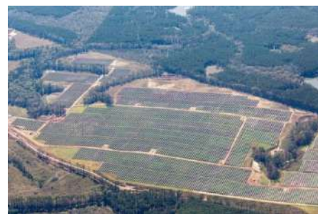
弗吉尼亚州项目现场 (98.3MW)
